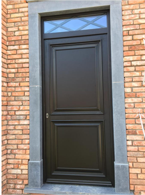
Foto : standaard type voordeur – bovenlicht voorzien van 2 verticale kleinhouten ipv 2 diagonalen zoals op bovenstaande foto
